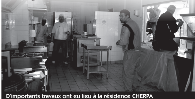
D'importants travaux ont eu lieu à la résidence CHERPA
