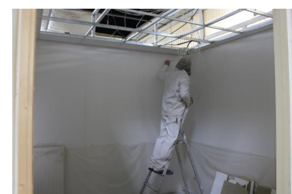
Atelier d'Insertion bâtiment
