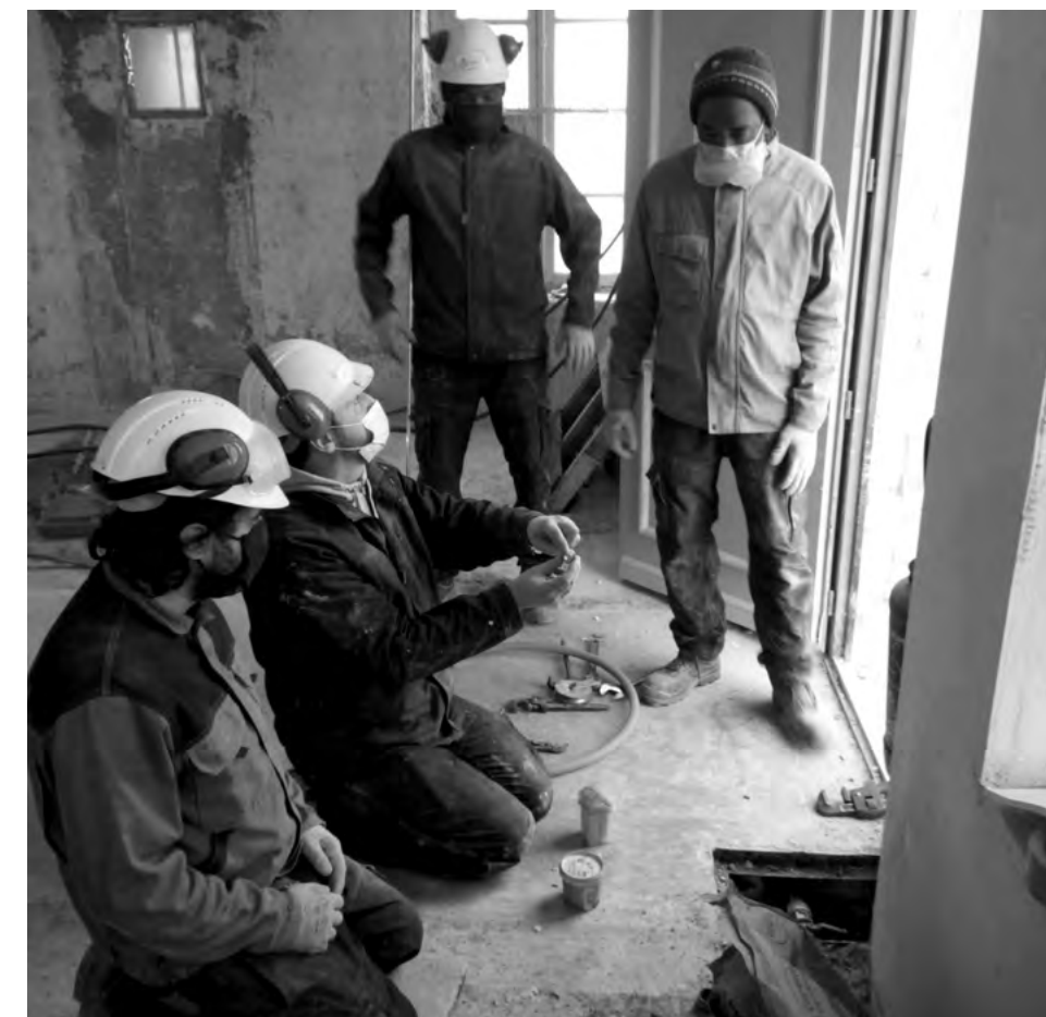
Les stagiaires en situation réelle de chantier Bâtiment
