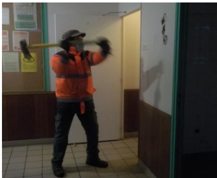
1 er coup de masse - démolition des cloisons de l'ancienne salle de repas – Janvier 2021
