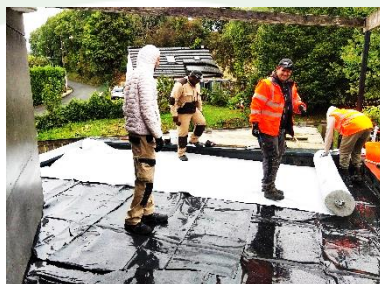
Mise en place d'une toiture végétale par le service Eco transition
