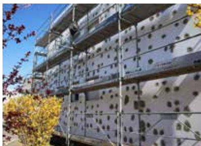
L'isolation du bâtiment du siège a été réalisée dès le printemps 2021
