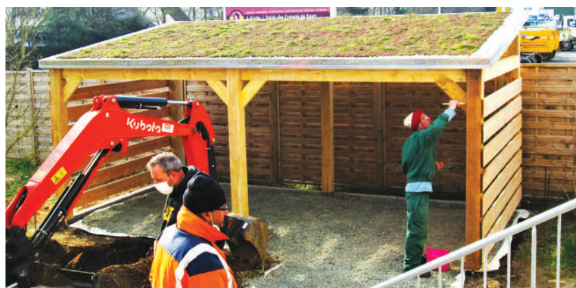
Construction d'un abri pour deux-roues
